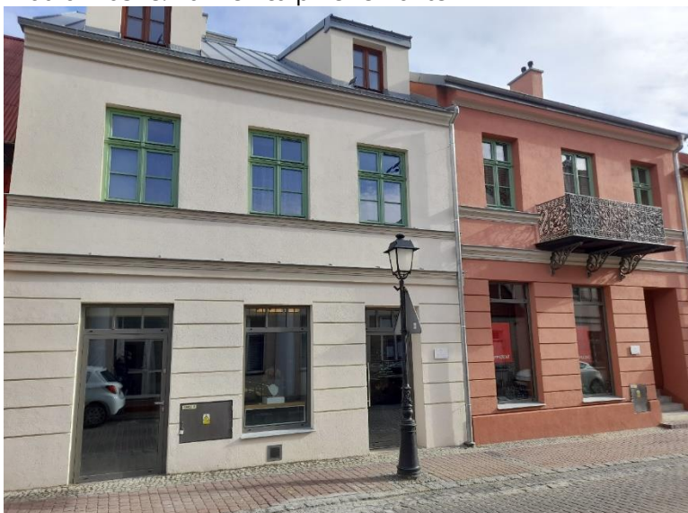
Źródło własne: Kamienica po remoncie
