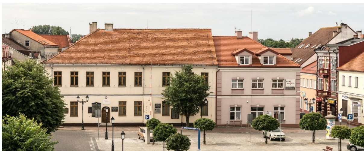
Źródło własne: Kamienica przed remontem
