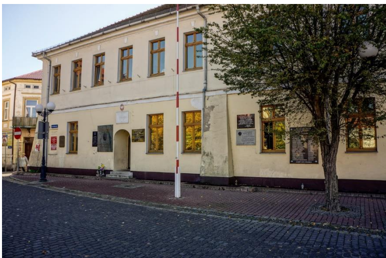
Źródło własne: Kamienica przed remontem
